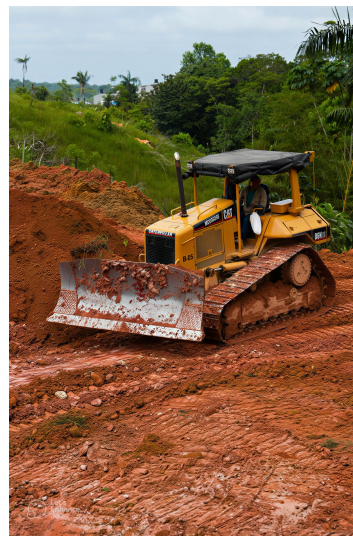
Maquinaria en obra — adecuación del terreno, Villa Itha
